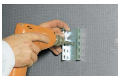
Pri izradi pregradnih zidova, oblagajućih elemenata za kade itd. kao pomoćna sredstva pri montaži koriste se tzv. priključne spojnice. One se šarafe na zid ili pod.
