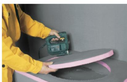
Odgovarajućom pilom možete napraviti najrazličitije forme i oblike iz ploče **Austrotherm UNIPLATTE®**, uključujući i one kružne i ovalne.
