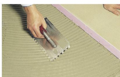
Ljeplilo perfektno prijanja - bez obzira da li je podloga estrih ("košuljica") ili beton. Ukoliko podloga nije noseća, onda se **Austrotherm UNIPLATTE®** mora tiplama pričvrstiti za nju.
